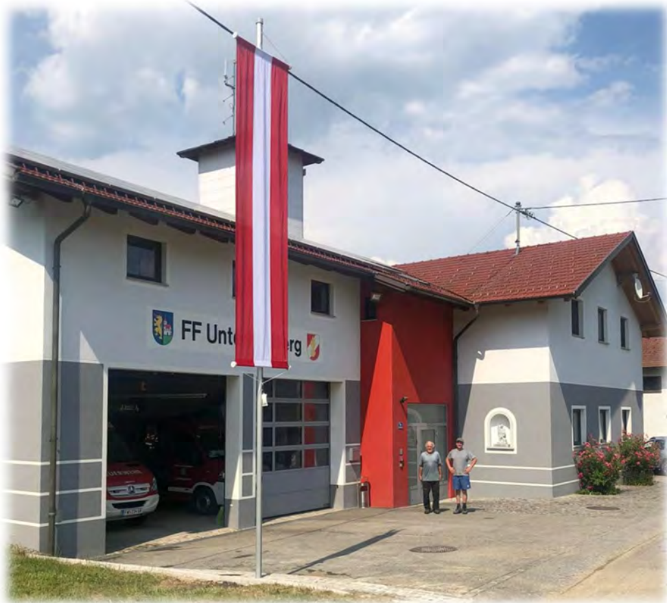
12. Jun. 21 Umbauarbeiten am Vorplatz des Feuerwehrhauses
